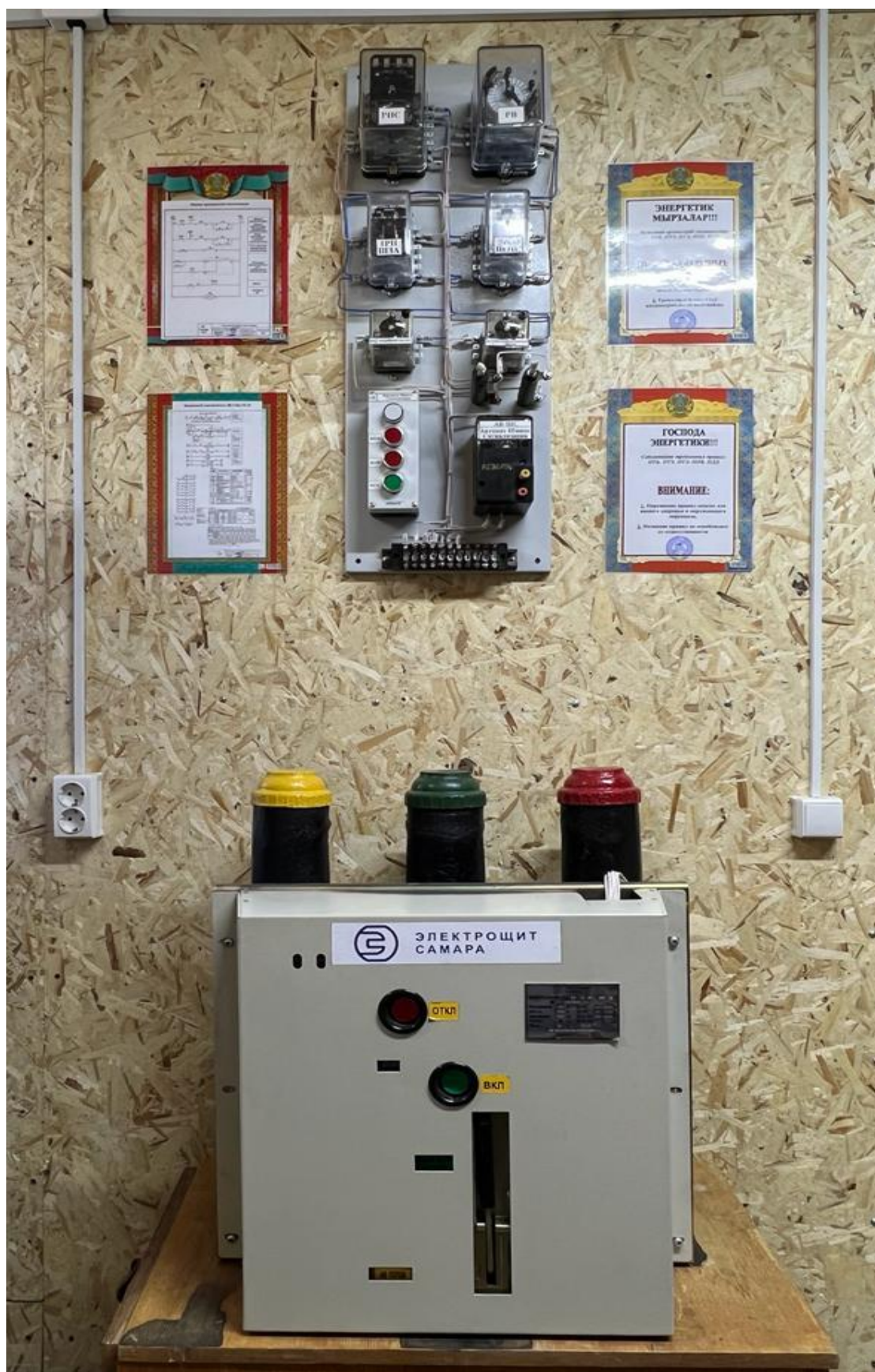
Қосымша 3-Орталық сигнализациямен вакумдық ажыратқыш
