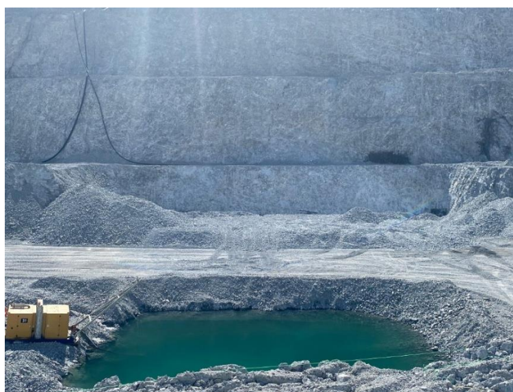
Рисунок 3 – Состояния откоса после заоткоски уступа.
