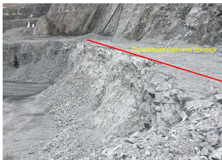
Рисунок 2 – Состояния откоса после отработки контурного блока.
