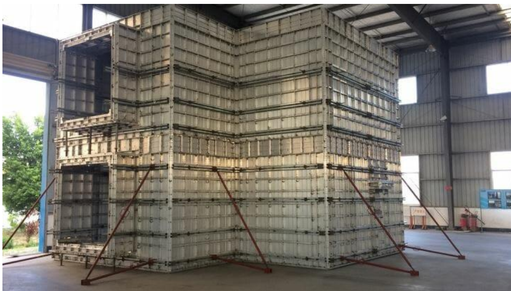
Рисунок 1. Технология опалубки Mivan алюминиевый каркас.
