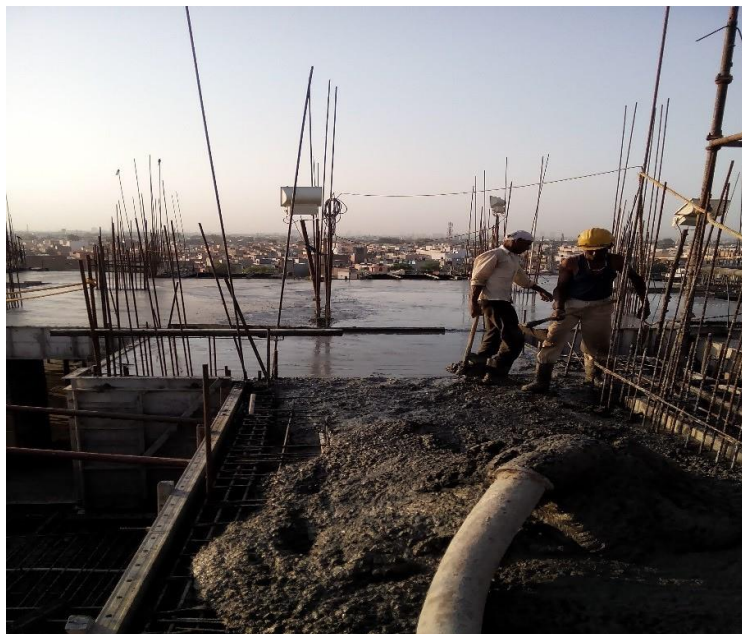
Рисунок 5. Показаны работы по бетонированию колонны, балок и плит.
